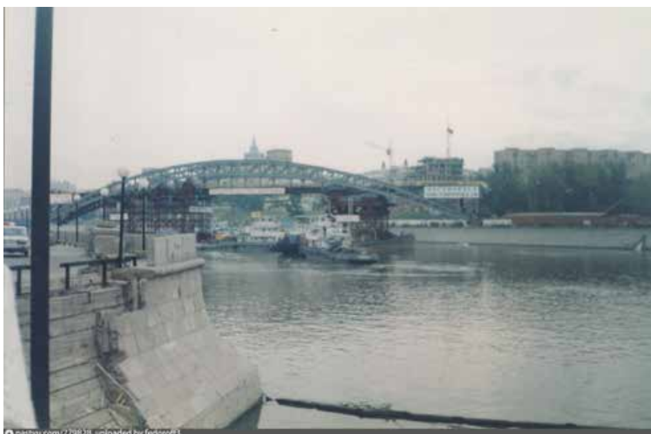
Установка старой конструкции моста на новом месте
